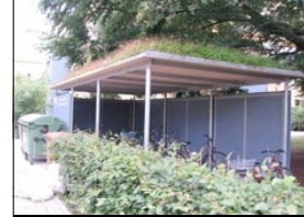
Abri à vélos à Vauban (D)
