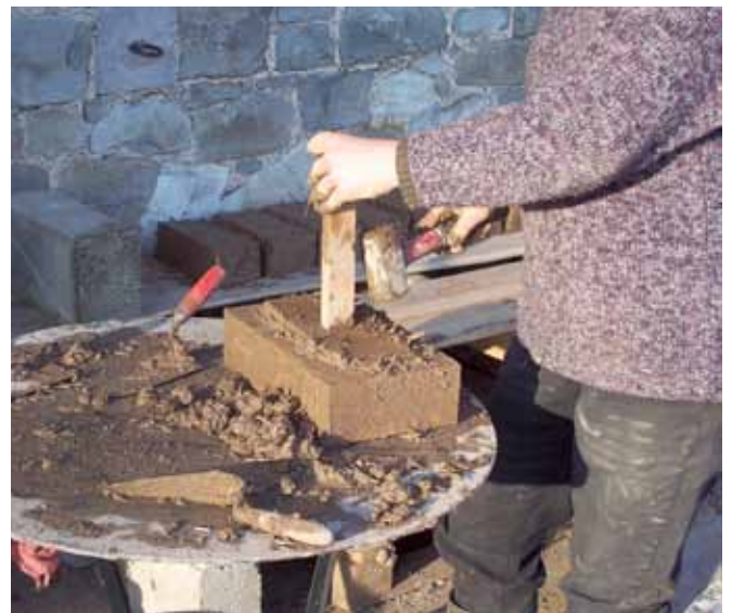
Moulage manuel des briques en argile
