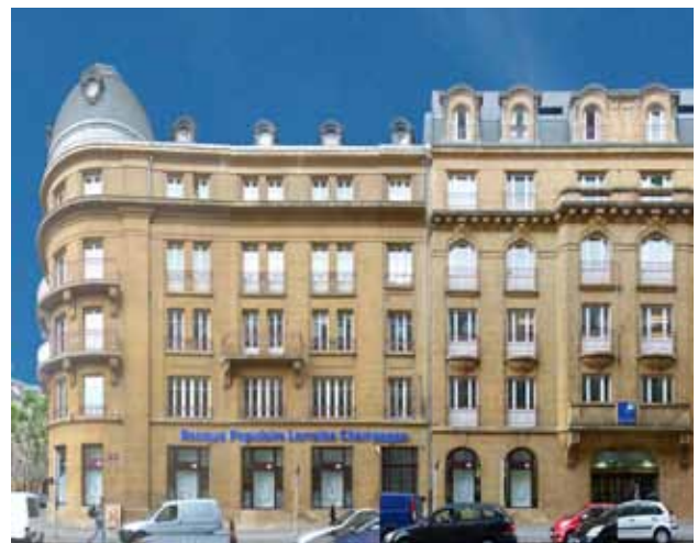
Ci-dessous: immeuble situé place Charlemagne à Metz, lauréat Prebat 2012 - ©BPLC
